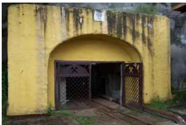
Abb. 9-1: Mundloch Stolln Pöhla, Zustand 2011
