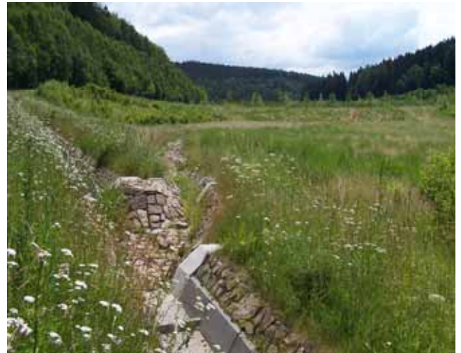
Abb. 9-8: Plateau der sanierten Luchsbachhalde mit Wasserableitungsgraben, Zustand 2011
