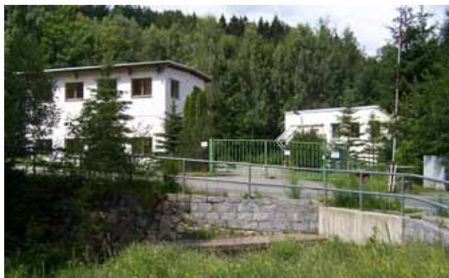
Abb. 9-4: Konventionelle Wasserbehandlungsanlage, Zustand 2011
