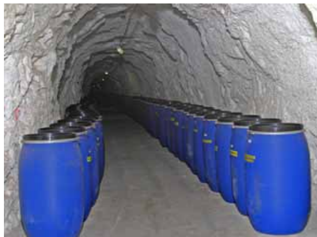
Abb. 9-5: Untertägige Einlagerung der Rückstände aus der Wasserbehandlung
